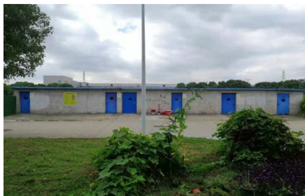
危险废物贮存场警示标志牌、观察窗、灭火器、消防沙箱
