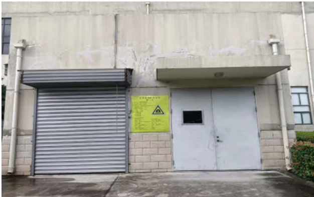
危险废物贮存场警示 标志牌和观察窗
